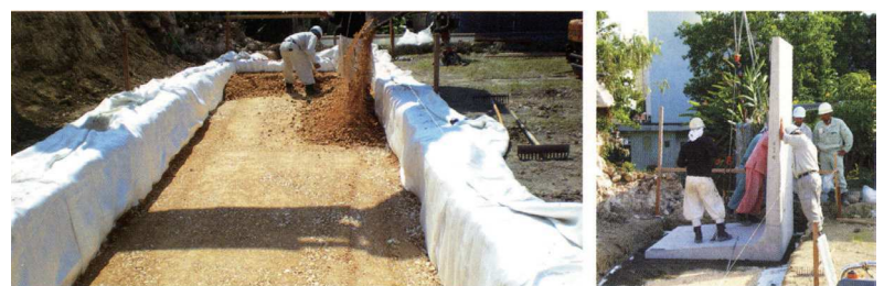
L型擁壁をしっかり支える
