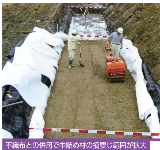
アダムで路床を補強
