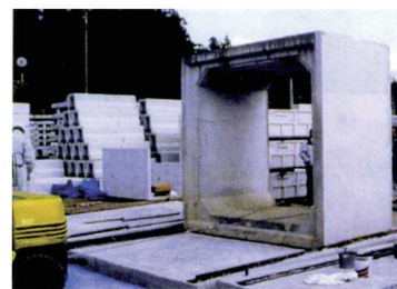
ボックスカルバート滑走状況
